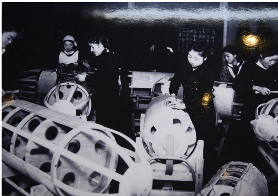
木製の飛行機部品を作る
