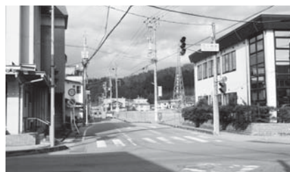
改良工事予定の千島松本線
