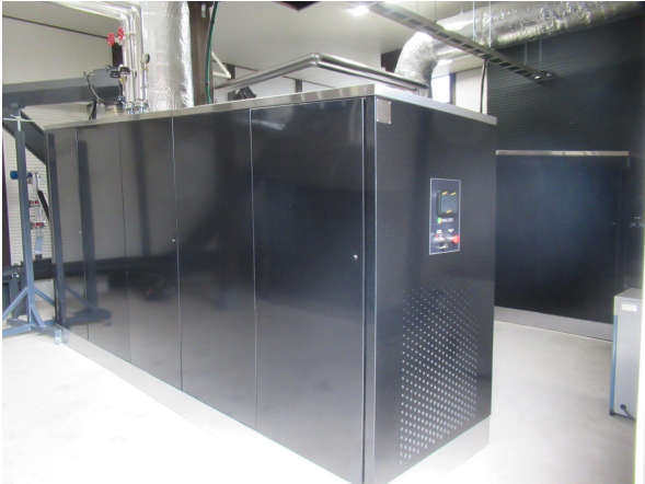
井上工務店 木質バイオマス熱電併給設備
