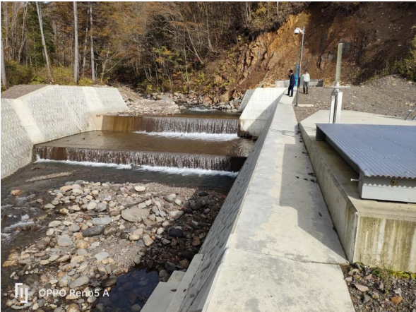
中尾地熱発電所
