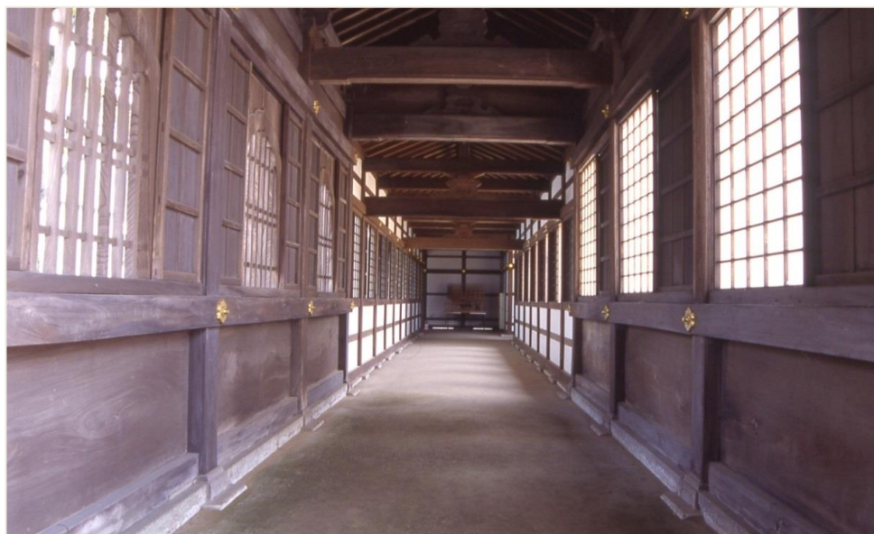
<内部修復完成後>
