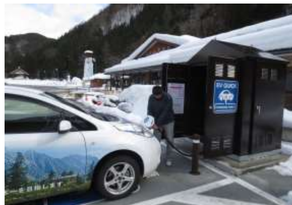
道の駅電気自動車用急速充電器の設置 〔朝日地域〕
