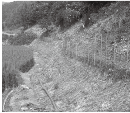
山地と農地の間に緩衝帯を作った刈払いの状況
