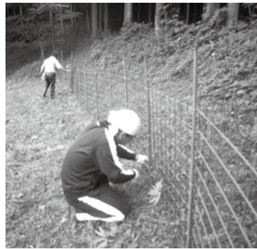
地域ぐるみで防護柵を設置
