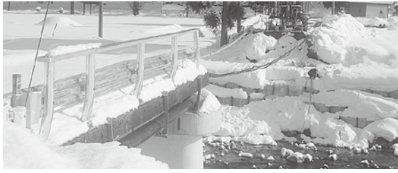
清見町河渡橋 工事現場
