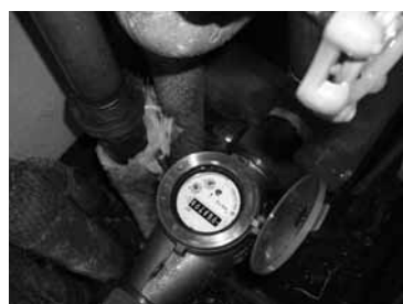
地下漏水の現地視察
