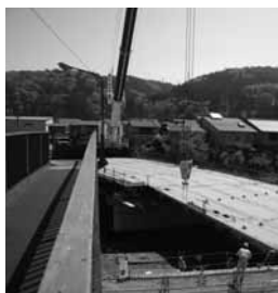
山王橋の作業現場
