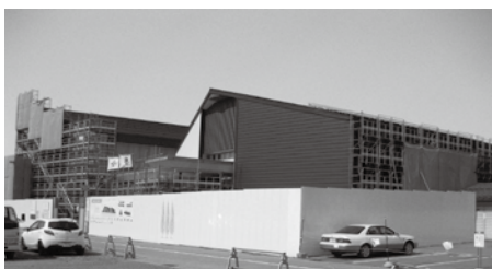
国府支所庁舎新築工事現場
