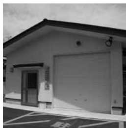
丹生川支団町方消防団車庫
