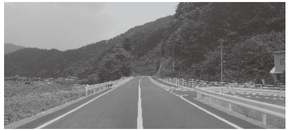
6月完成の市道八日町下林線改良工事
