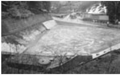
錦山配水区域再編事業における江名子配水機場予定地
