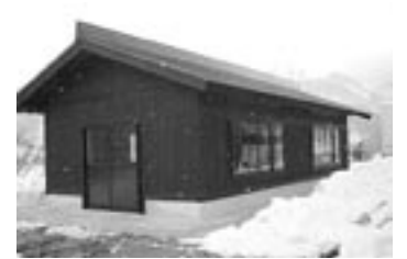
五味原ふるさと公園管理棟 (丹生川町五味原)
