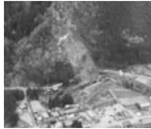
日面芦谷線災害現場
