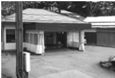
老朽化の進む高山火葬場
