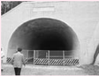
上ヶ洞トンネルの坑口
