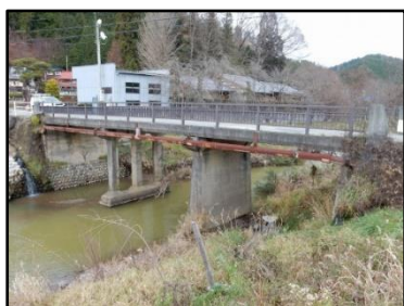
三福橋(L=21.7m) 1967 架設
