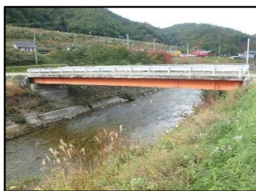
二本木橋(L=26.6m) 1977 架設
