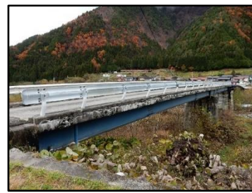
田頃家橋(L=149.7m) 1973 架設
