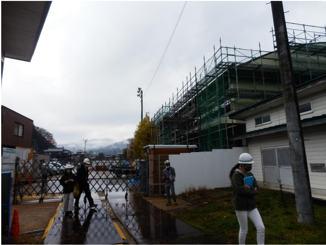
写真 1 監査当日の現場外観写真
