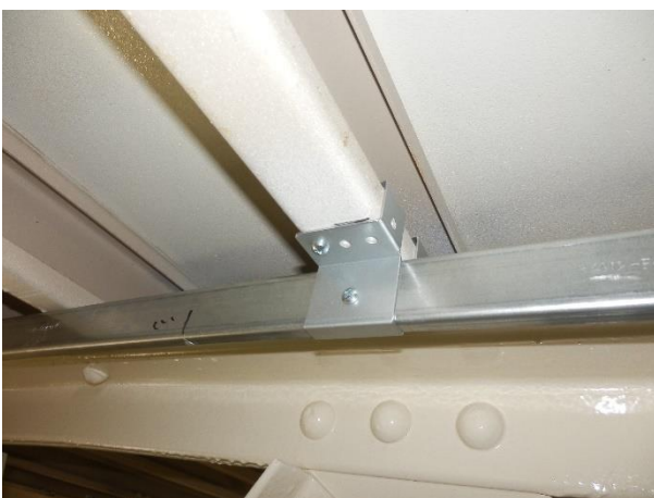
写真10 天井下地取付金物状況
