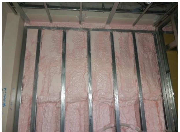
写真 5 ウレタン断熱施工状況
