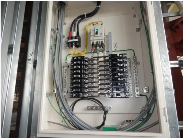
写真8 電気設備施工状況
