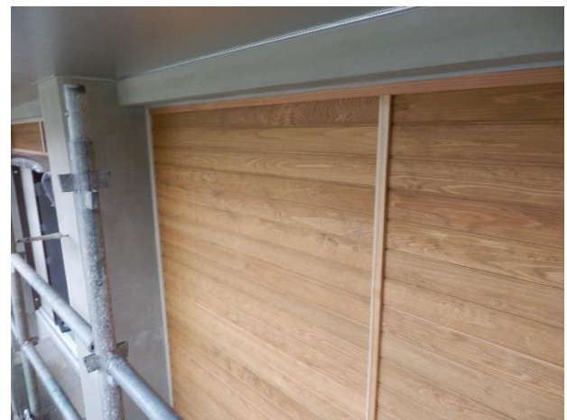
写真 15 桧羽目板施工状況
