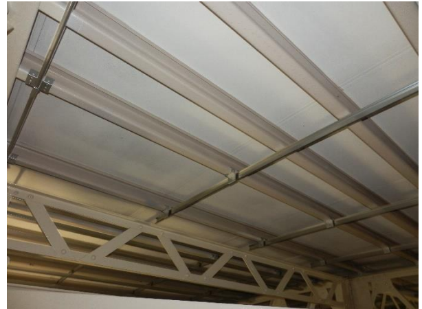
写真9 天井下地取付け状況
