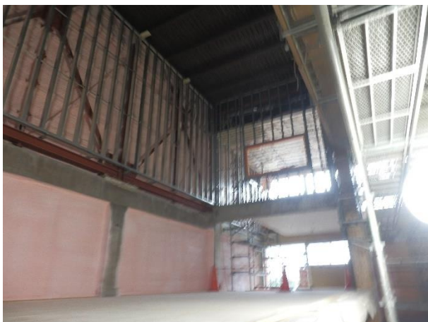
写真 4 ステージ下地処理状況
