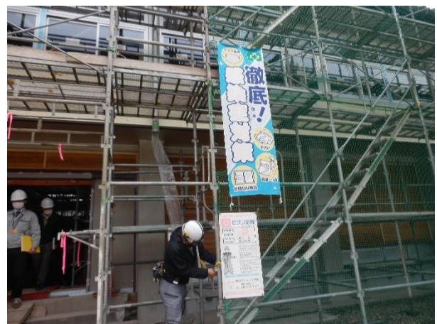
写真11 安全標語啓蒙状況
