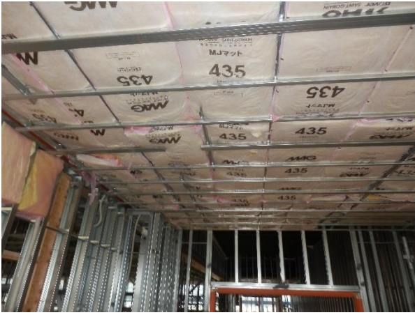
写真6 断熱材施工状況
