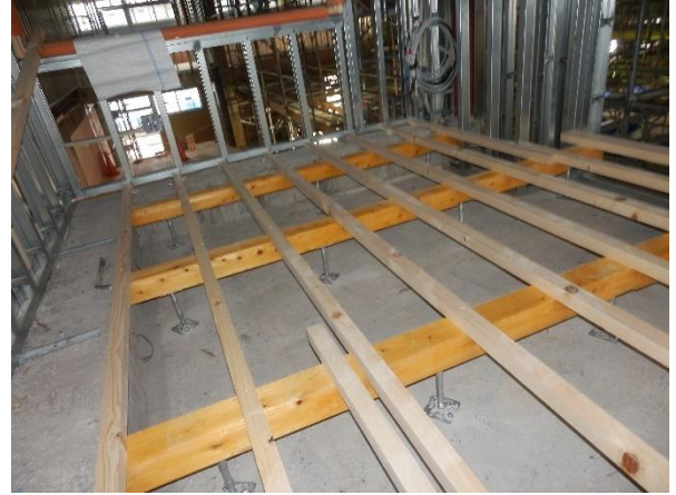
写真7 床下地組施工状況
