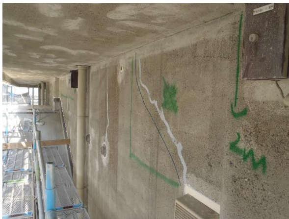
西面 事務所棟 外壁現況
