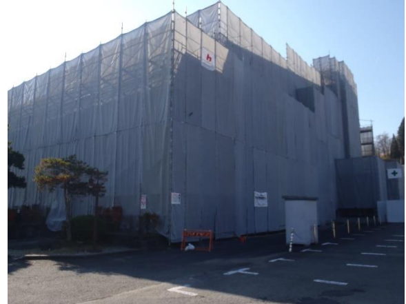
外部 北面 現況
