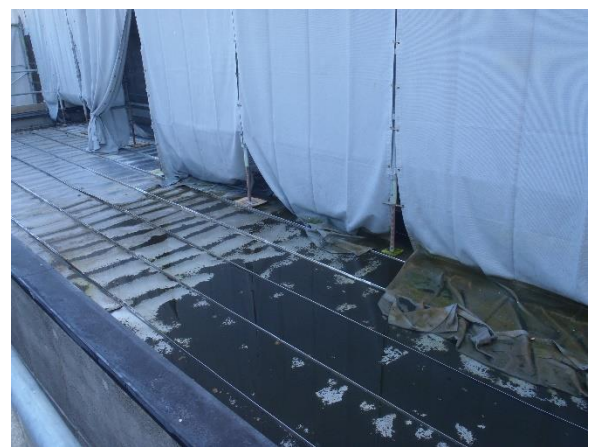
屋上 ステージ横倉庫 屋根現況
