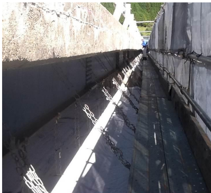
【 立会状況 足場の設置- 1 】
