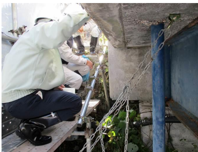
【 立会状況 足場の設置- 2 】
