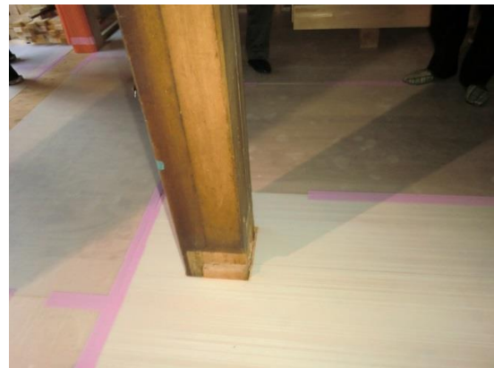
柱（下部梁撤去部ほぞ穴埋め）
