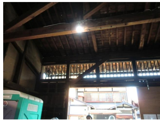
蔵倉庫（既存木造トラス ボルト追締め）
