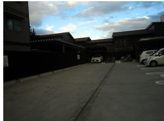
外観（西面 蔵 外周面板塀）
