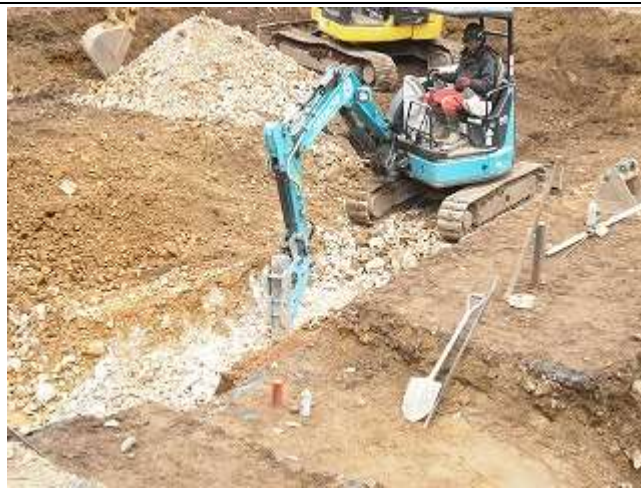
写真.3 構造物基礎の地中梁部の掘削状況
