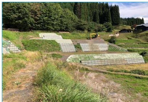
完成部分の状況(カゴ枠工・大型カゴ枠工)
