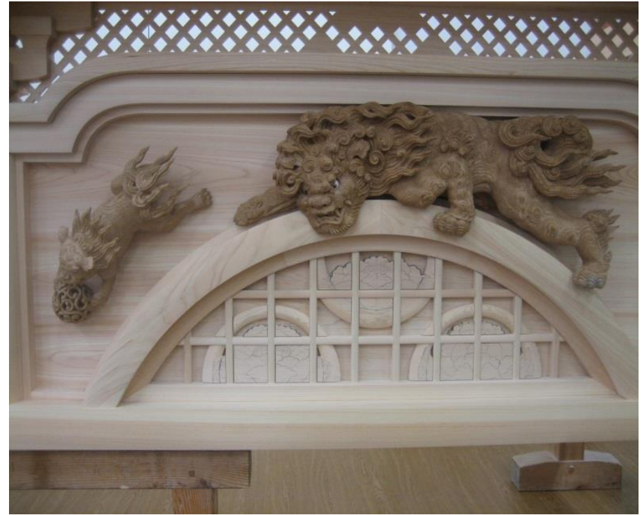
彫刻取付状況
