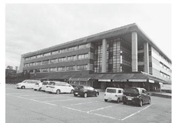
築31年を経過した市民文化会館
