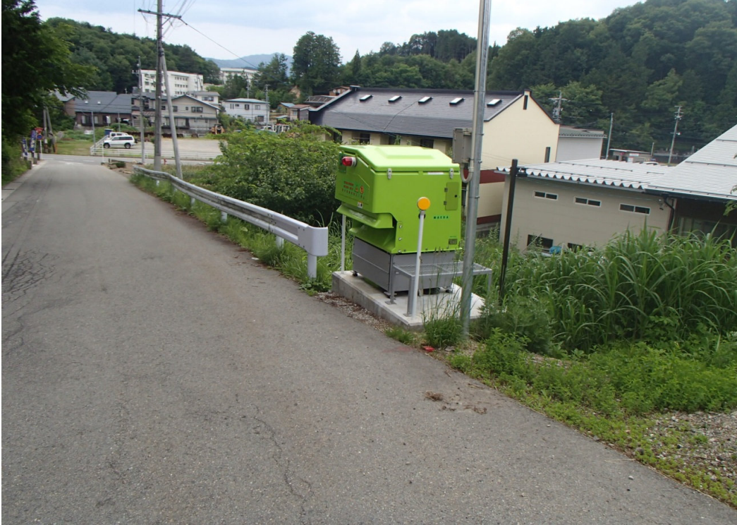
25基維第137号 凍結防止剤自動散布機設置工事①
