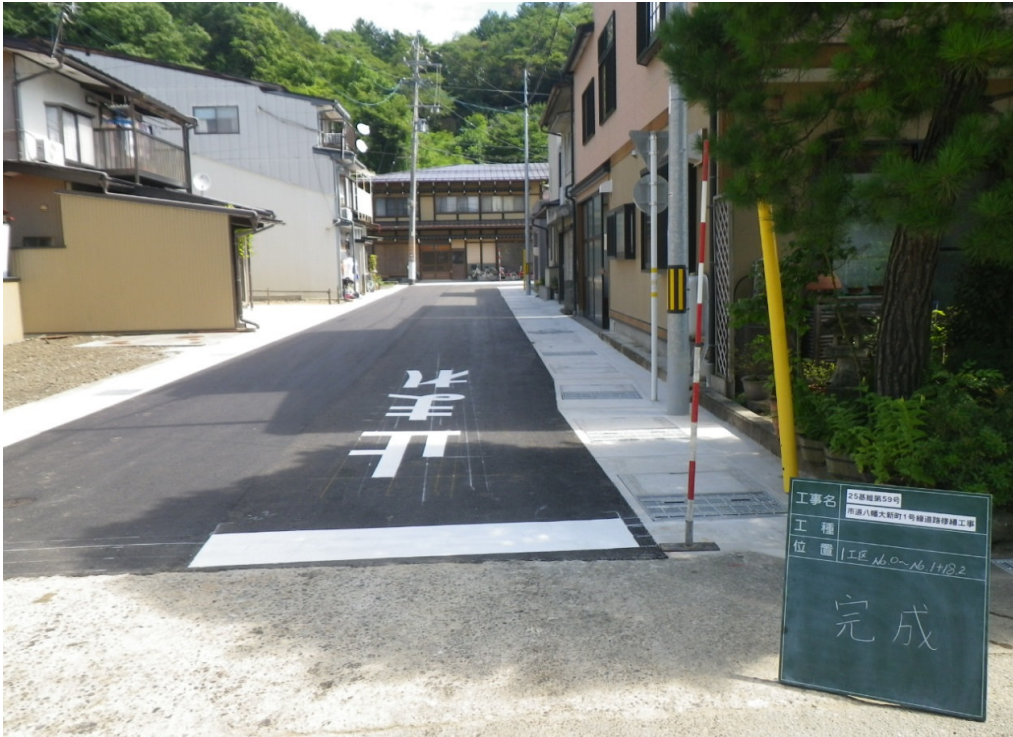
25基維第59号 市道八幡大新町1号線
