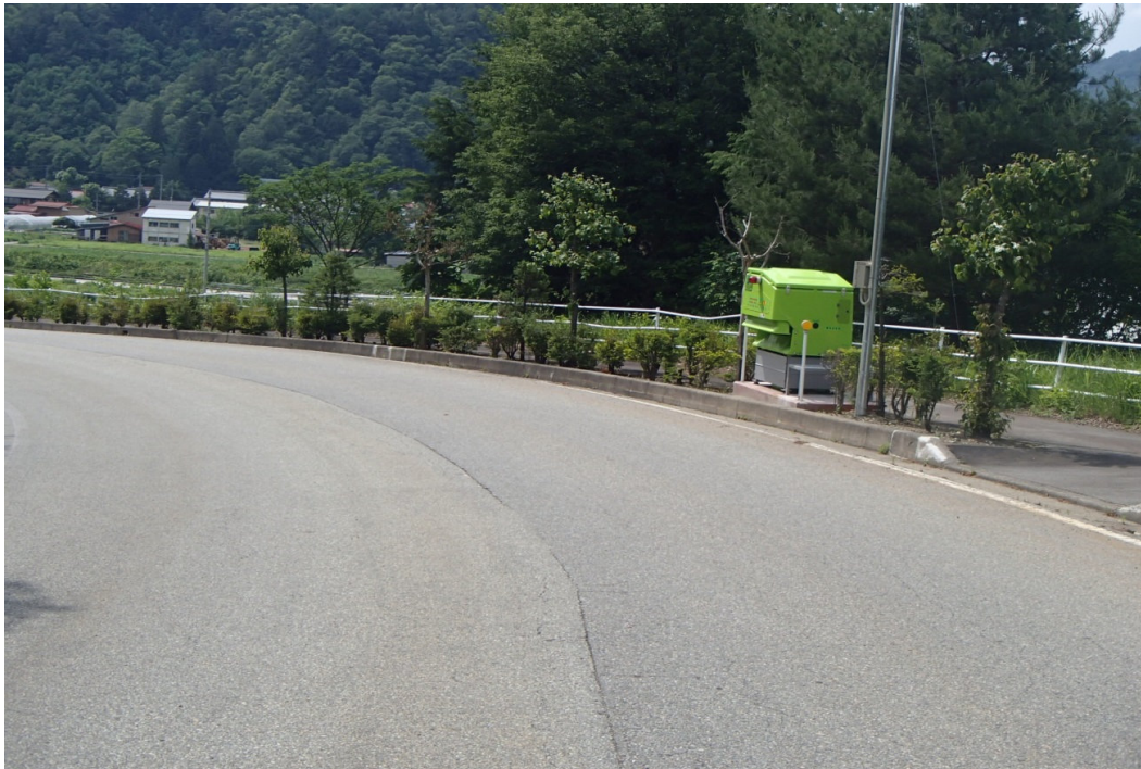
25基維第138号 凍結防止剤自動散布機設置工事②
