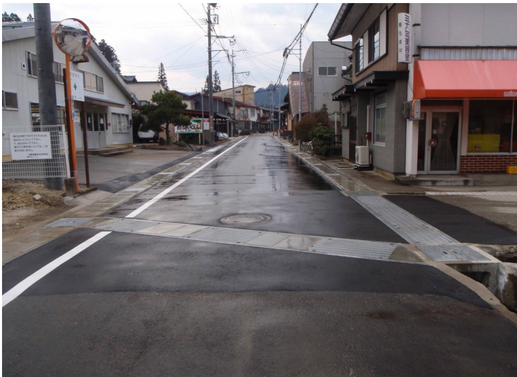
25基維第189号 市道八幡大新町1号線（八幡町）
