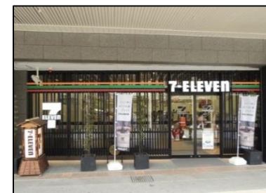
景観に配慮された店舗
