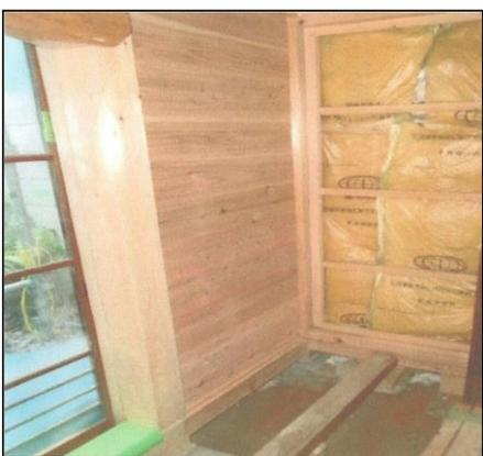
復元力の大きい耐力板壁による補強
