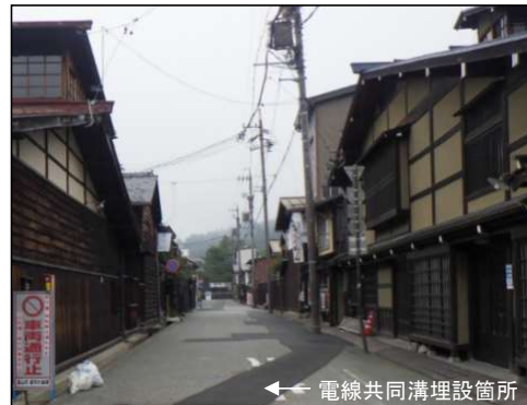
無電柱化工事写真(令和3年)
