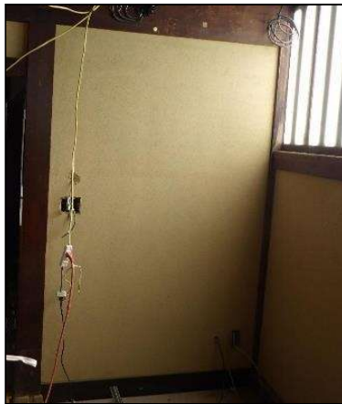
耐力壁工事完了後(左官後)
