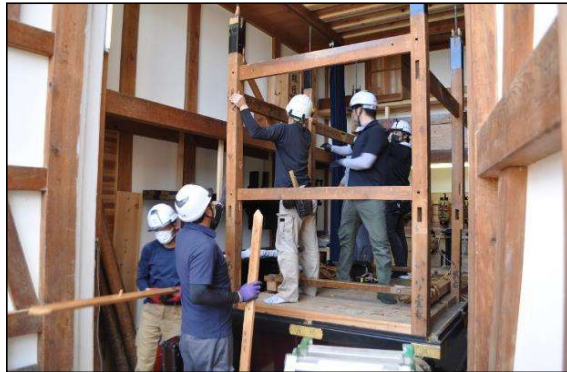
仙人台の解体
