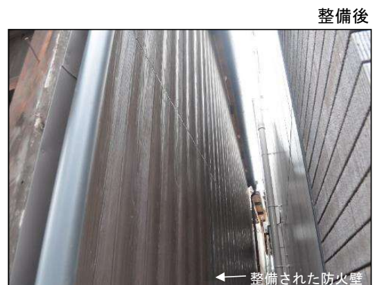
伝統的建造物群保存地区防災対策事業により整備が行われた防火壁整備
