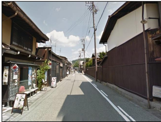
無電柱化予定路線の現状
