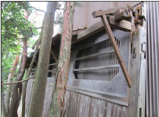
角正庭園竹塀修繕工事
