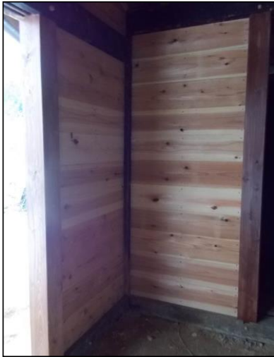
耐力壁(板壁)の設置による耐震化
