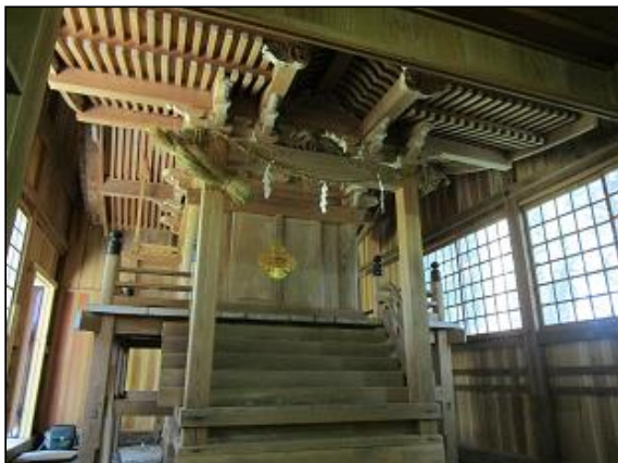
岩井神社本殿修繕状況
