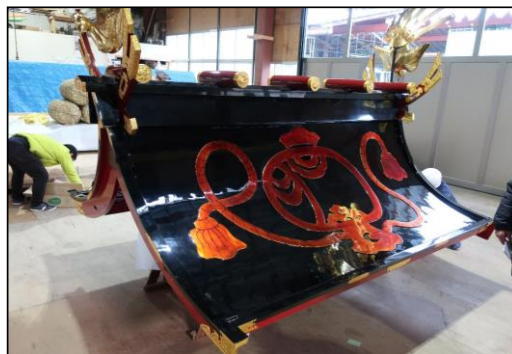
大国台の屋根の修理状況
