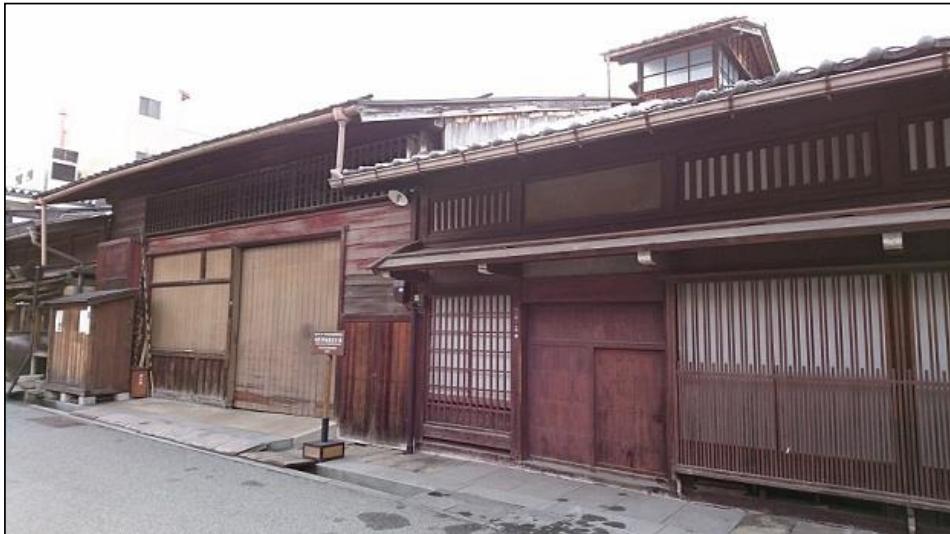
改修予定の「旧村田邸」の主屋(右)及び倉庫(左)
