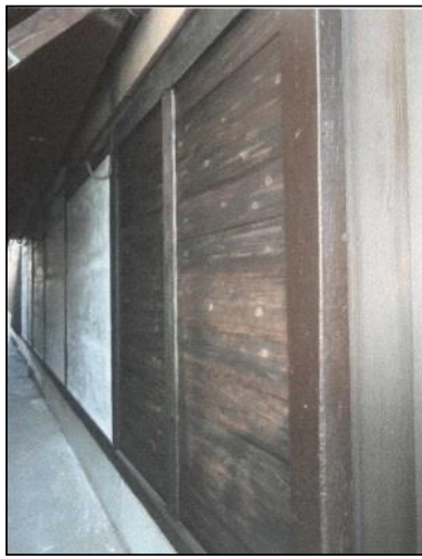
耐力壁の設置による耐震化
