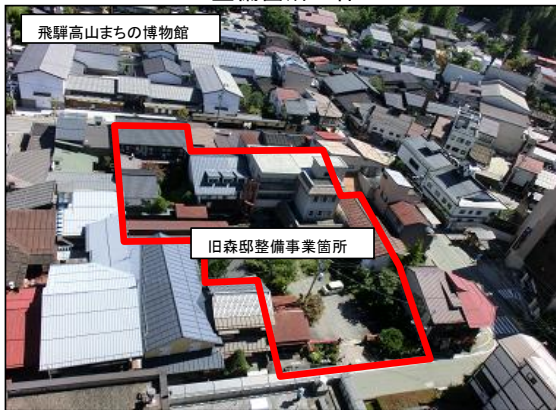
整備箇所全体
