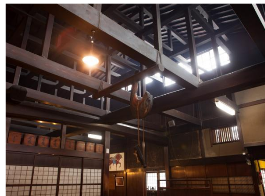
日下部家住宅の外観と内部(松田一門)
