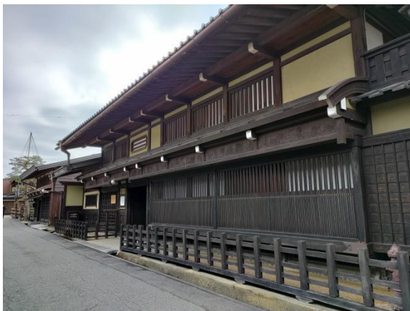
国の重要文化財 日下部家住宅
