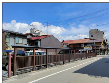
板塀を設置した駐車場 R5.10
