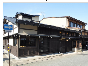
伝統的建造物群保存地区 保存修理事業 R3
