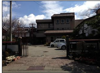
旧図書館本体(解体予定)
