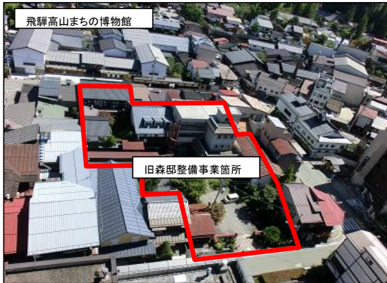
整備箇所全体
