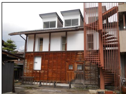
旧図書館土蔵(改修予定)
