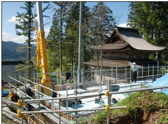
安国寺経蔵防災設備改修工事
