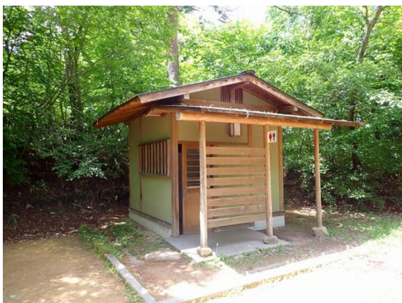
城山公園 公衆トイレ（金竜ヶ丘）
