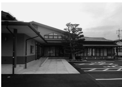
完成した集会所施設
