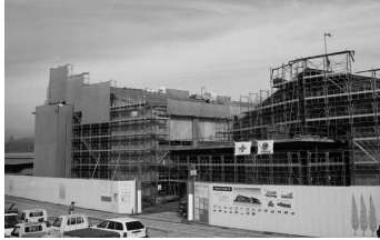
建設が進む 国府支所庁舎
