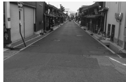
電柱が撤去された伝建地区
