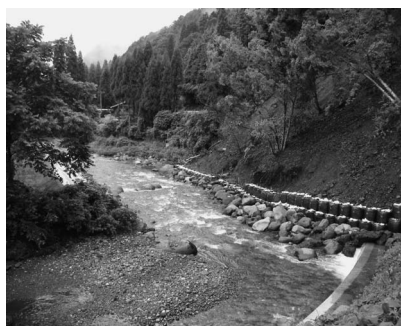
応急対策後(7月22日)の状況
