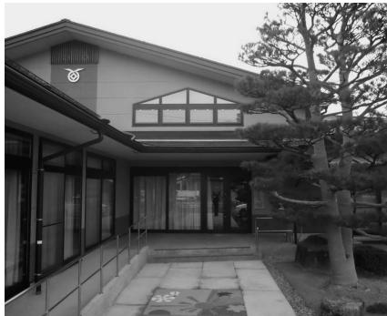
町内会集会施設の建設を支援しました (写真は石浦公民館)
