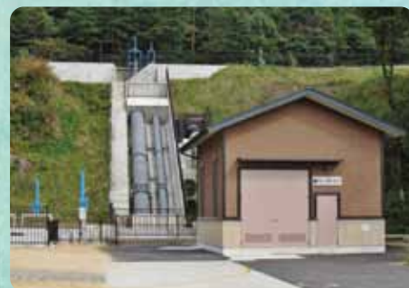
農業用水路を利用した長野の町川発電所
