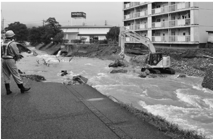
苔川で早朝から始まった応急復旧作業 (18日午前7時12分)
