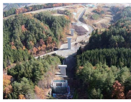
■中部縦貫自動車道 高山IC～丹生川IC(仮称)の工事
