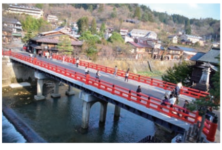
■中橋の耐震補強
