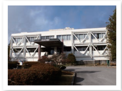
■下水道センターの耐震補強
