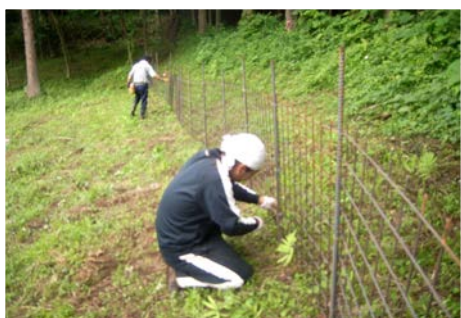
■ 侵入防止柵の設置
