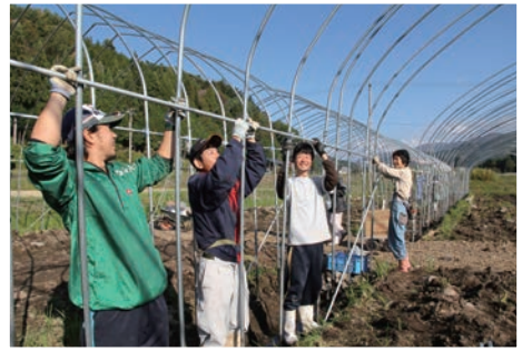
■ 新規就農者の「結」によるハウス組立作業
