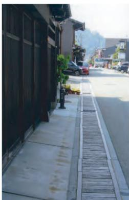
のふたのビスの取付が不良だったため、5000本の取り替えを行なった・側溝のふたの塗装をした
