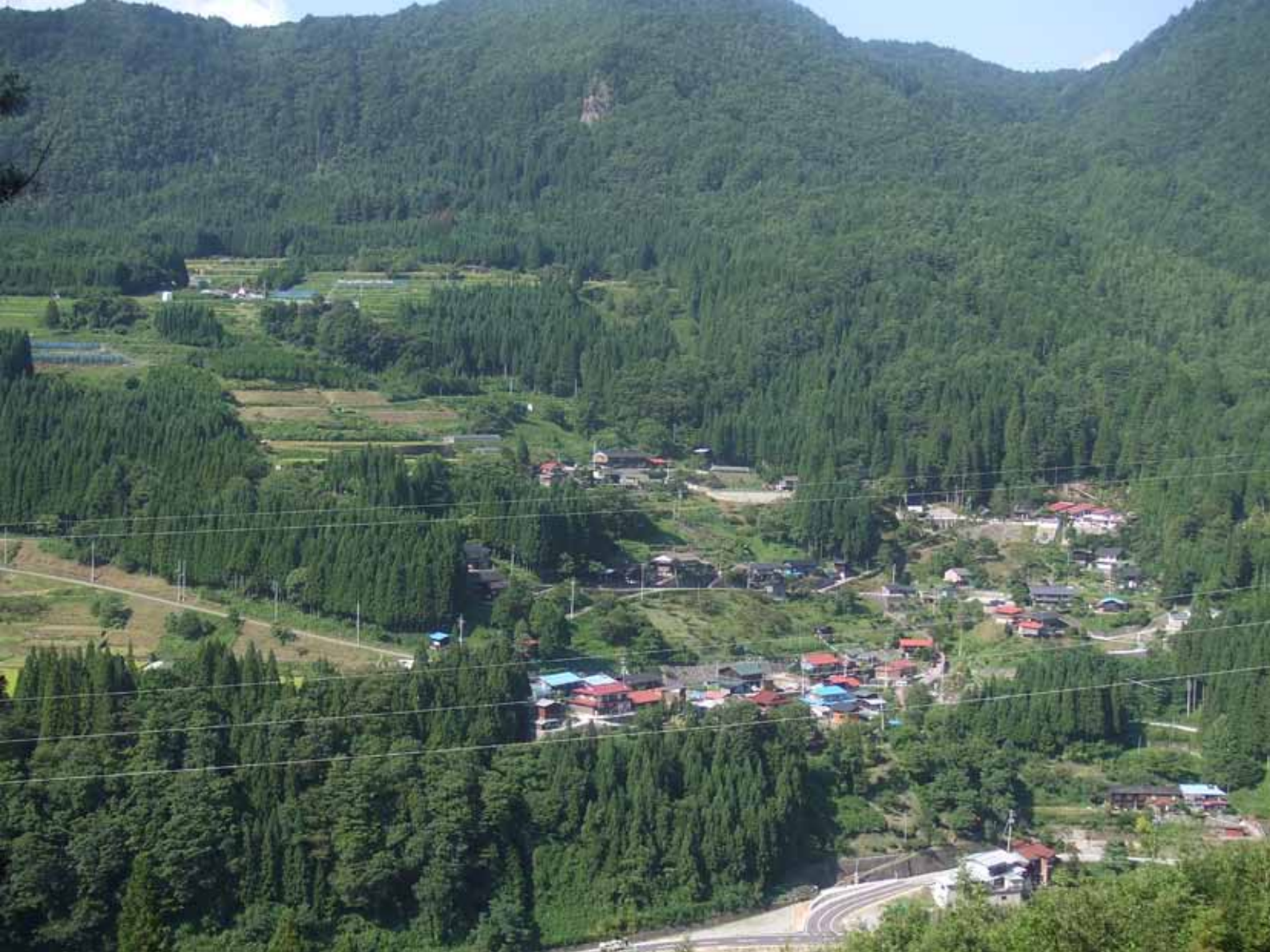
写真：向かいの山から望む長倉地区全景
